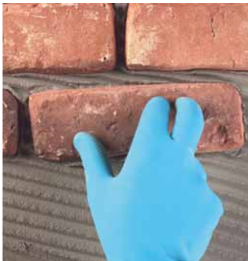
Příklad lepení obkladových pásků z vylehčeného cementového konglomerátu v exteriéru
