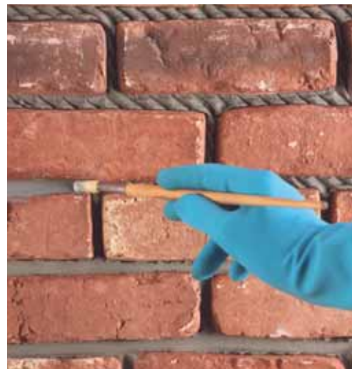
Vyhlazení spáry vlhkým štětcem
